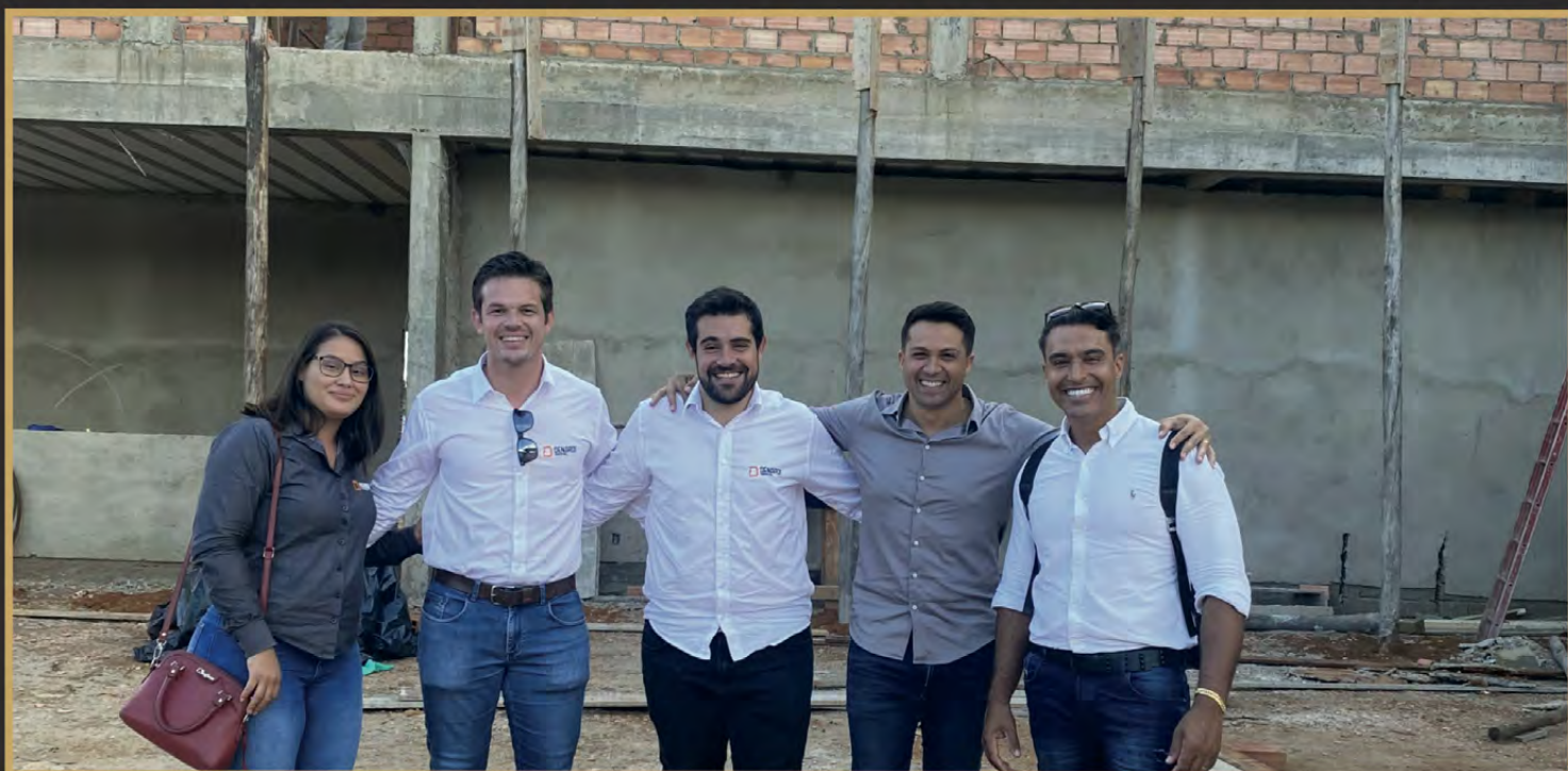
O empresário Elson Ramos cercado pelas equipes de arquitetura e engenharia em dia de vistoria na obra do seu novo Ditado Popular Primavera do Leste , que inaugura em breve como opção gastronômica e de entretenimento
